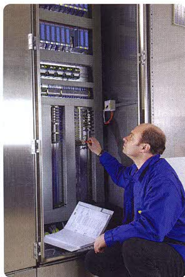
Bild 6: Übersichtlich und wartungsfreundlich – das modulare IO- und Steuerungssystem 2005 von B&R in Aktion bei Veltins.
