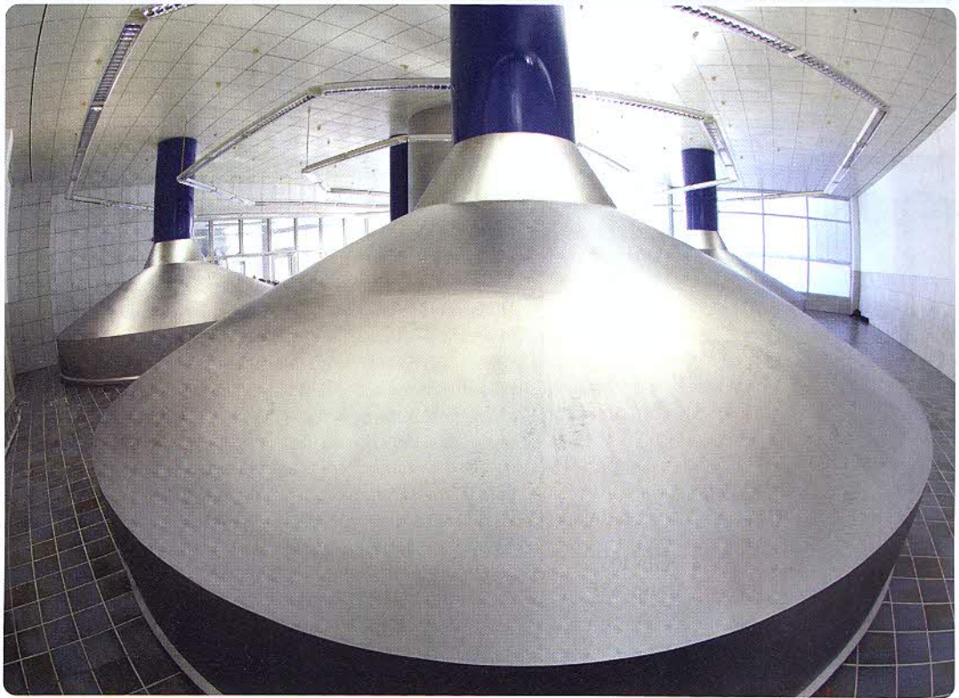
Bild 1: Würzpfannen bei Veltins zum Kochen der Heiwrze. Ab hier bernimmt das Prozessleitsystem Aprol das Kommando.
