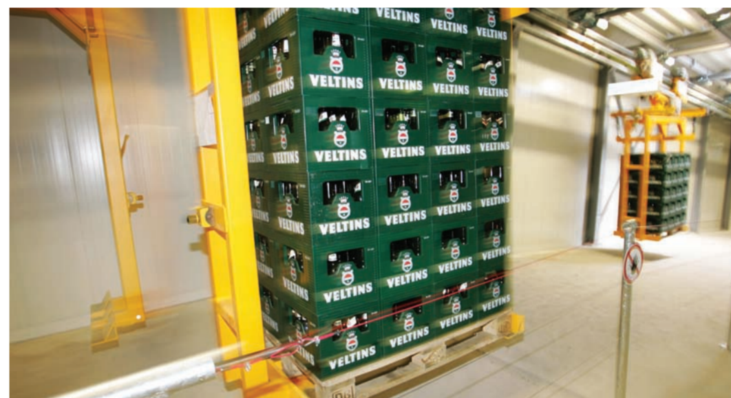
Auch bei der im Jahr 2007 installierten neuen Abfüllanlage bei Veltins war die CAD/CAE-Software Cadison eingebunden: Die Planung aller Rohrleitungen zur Anbindung der Abfüllstationen an den Brauprozess, der Einsatzort für die Waschmaschine, den Pasteur und die CIP-Reinigung usw. wurden wie immer intern vorgeplant, an externe Dienstleister zur Feinplanung übergeben und schließlich wieder zur Dokumentation an Cadison übergeben. Im Bild: Paletten gondel zwischen Abfüllung und Sortieranlage.
